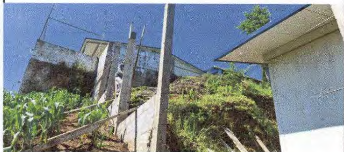
Foto 7: Muro perimetral en proceso de reconstrucción.
