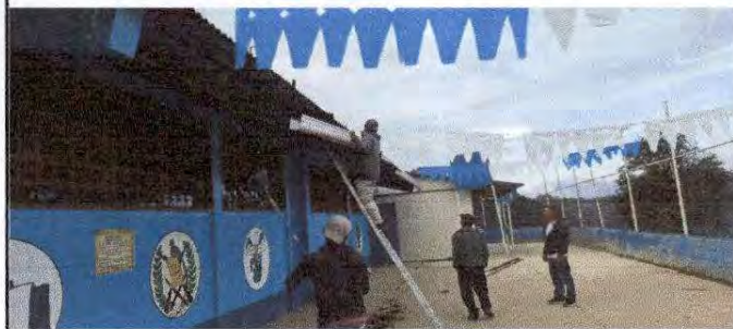
Foto 4: Se están sustituyendo canales y bajadas de agua deteriorados y en mal estado.
