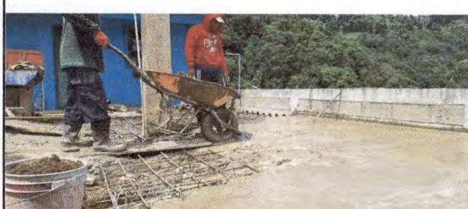
Foto 8: Patio de cocina escolar en proceso de reparación con colocación de planchas de concreto.
