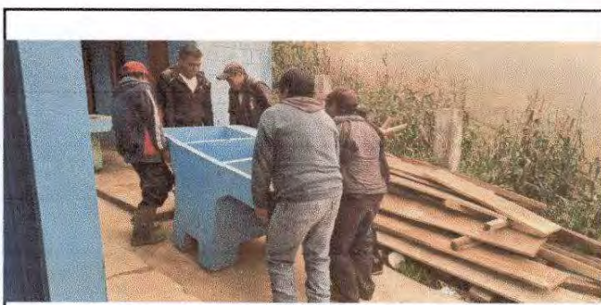
Foto 12: Traslado de pila de cemento de dos lavaderos en el lugar correspondiente.
