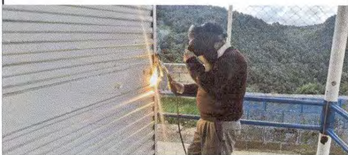
Foto1: Se están instalando chapas a puertas de metal.
