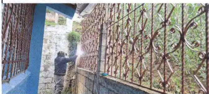
Foto 6: Se está instalando barandas nuevas por deterioro de las anteriores.
